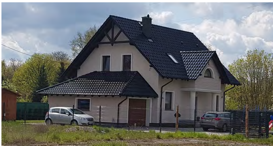
Fot. 2. Budynek mieszkalny jednorodzinny w Zielonej Górze przy ul. Urszuli
